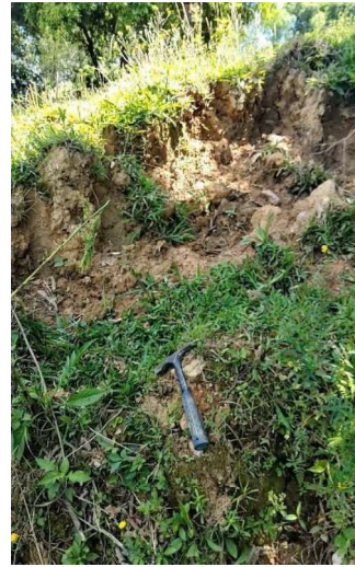
Figura 7- Degrau de abatimento em depósitos (pedogenizado para cambissolos háplico).
